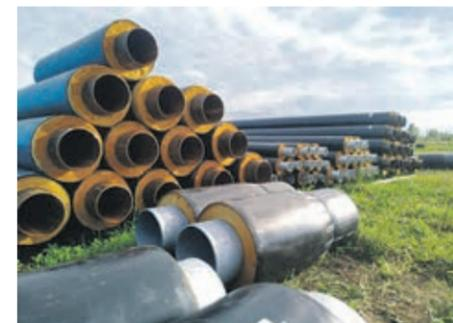
Специалисты УТК завершили капитальный ремонт аварийных участков сетей теплоснабжения на улицах Овражной, Домостроителей и Промышленной в поселке Октябрьском. Вместо изношенных теплотсетей были установлены стальные трубы, сконструированные по самым современным технологиям, а также имеющие длительный срок службы и уникально низкий коэффициент теплопроводности. Всего отремонтировано около 300 метров инженерных сетей.
