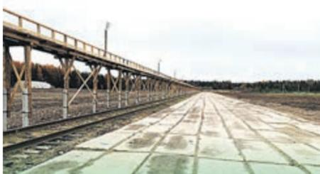
В терминале Няндомы, входящем в состав Плесецкого леспромхоза, ведутся активные работы по благоустройству территории. Специалисты подразделения завершили частичную замену бетонного покрытия. Сейчас они производят капитальный ремонт эстакады погрузки, а также проводят земляные работы по планировке площадки для складирования пиловочника.
